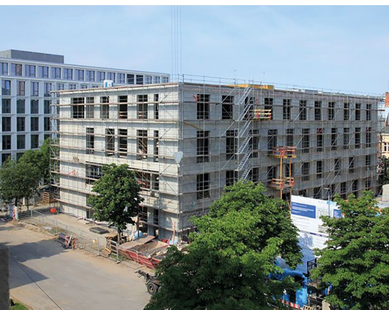
Abb. 2: Die Bauarbeiten des PTB laufen auf Hochtouren
